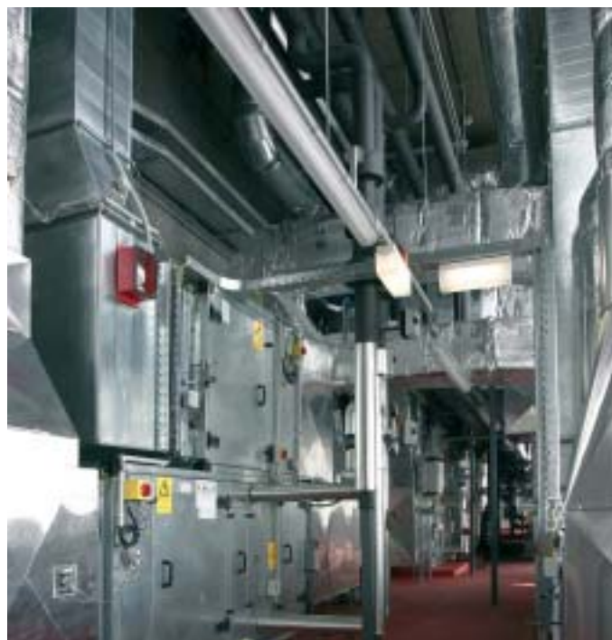
Jobbra fent: A központi előadóterek számára különálló légkondicionáló rendszer biztosítja a megfelelő légállapotot
